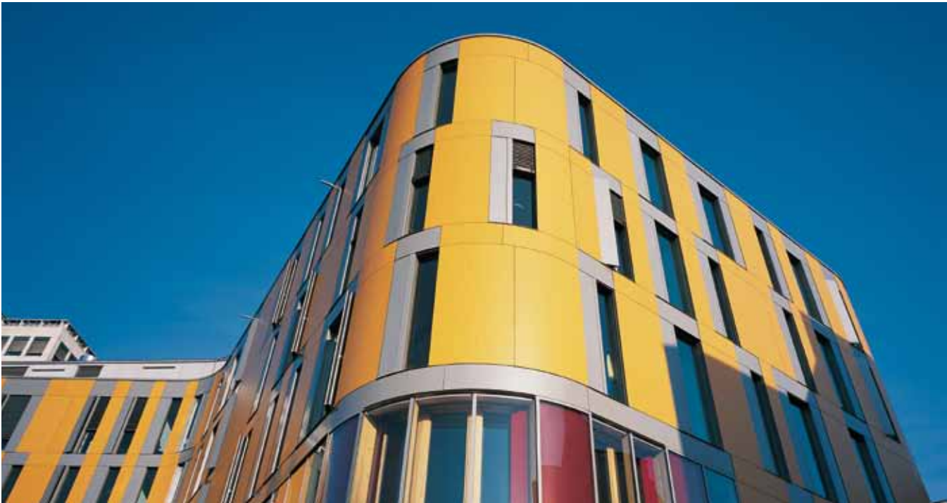
Kreishaus Aachen, Aachen, Deutschland | Administration Building, Aachen, Germany | Heuer Faust Architekten | © www.rs fotografie.de
